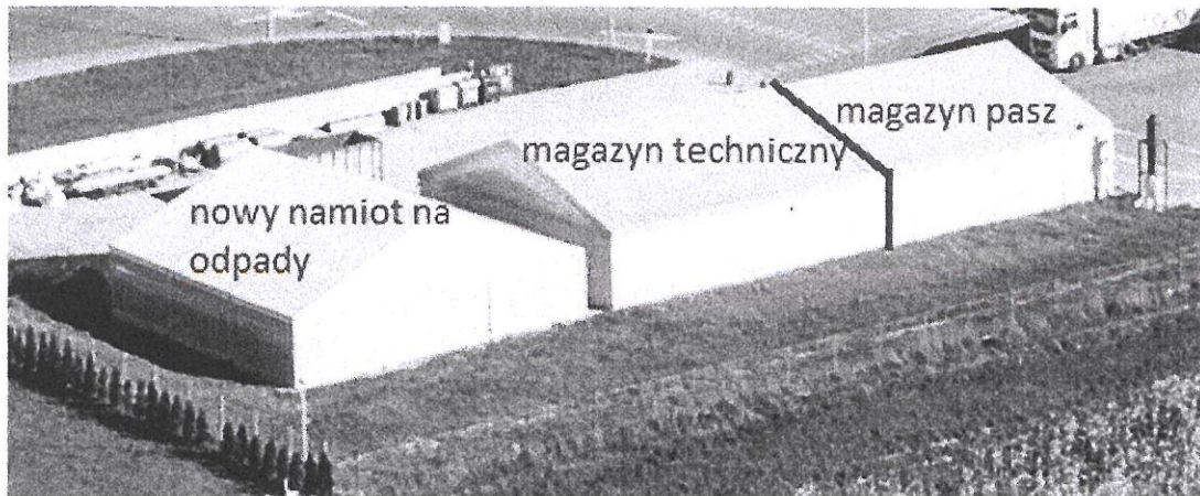
Widok na halę magazynową namiotową na odpady
