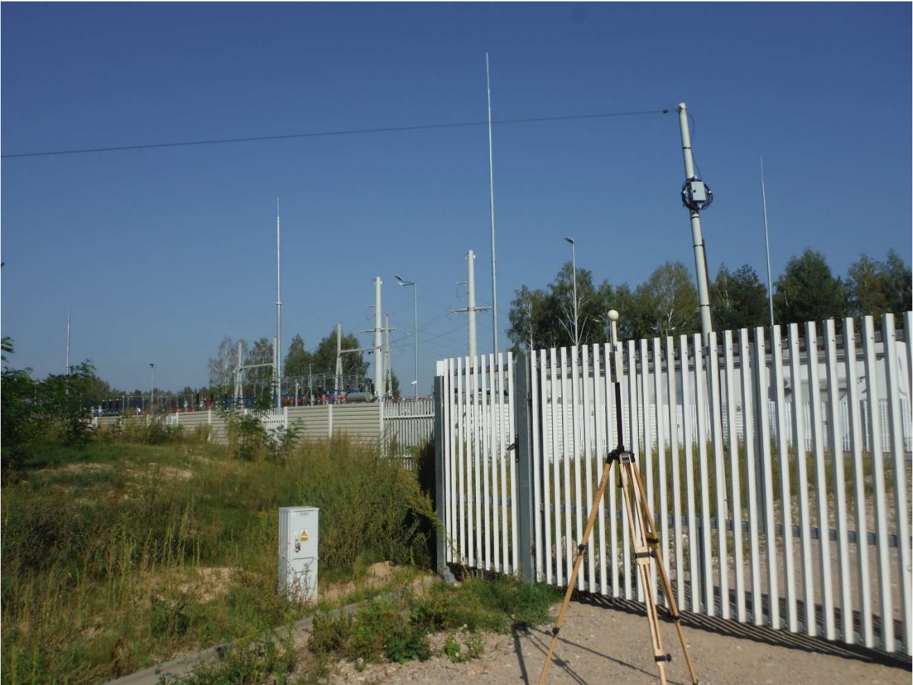
Zdjęcie 1 Badany obiekt
