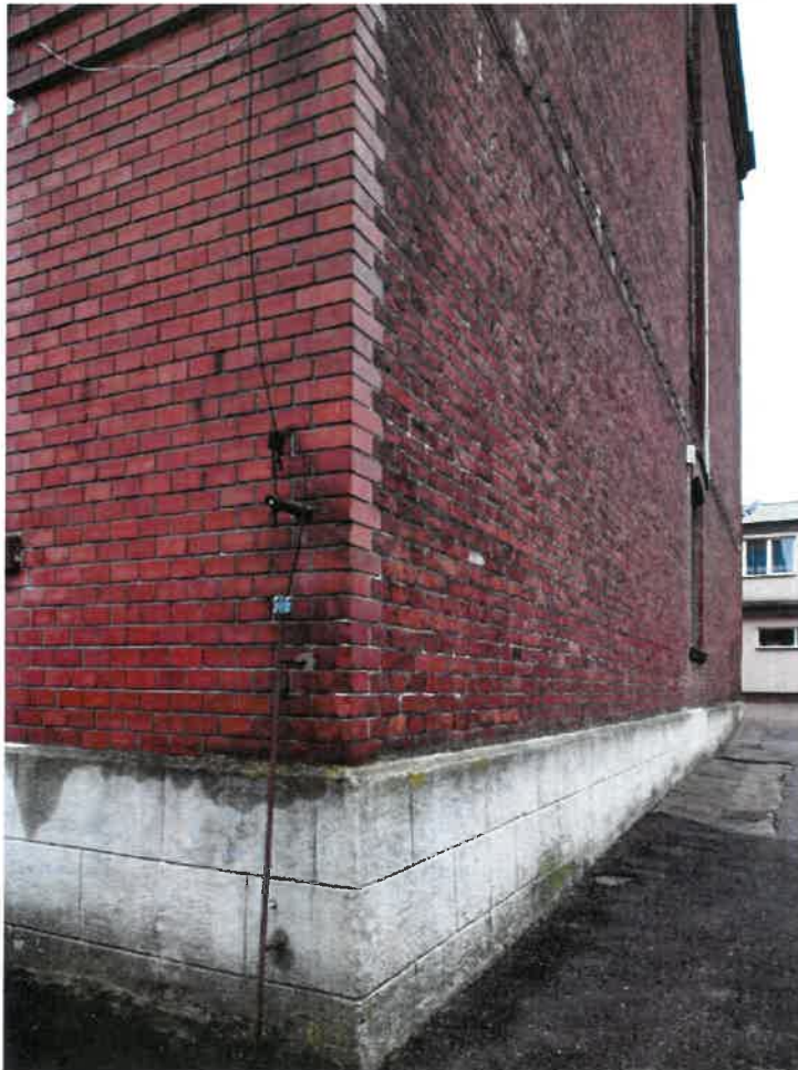
Styk elewacji frontowej i zachodniej.
