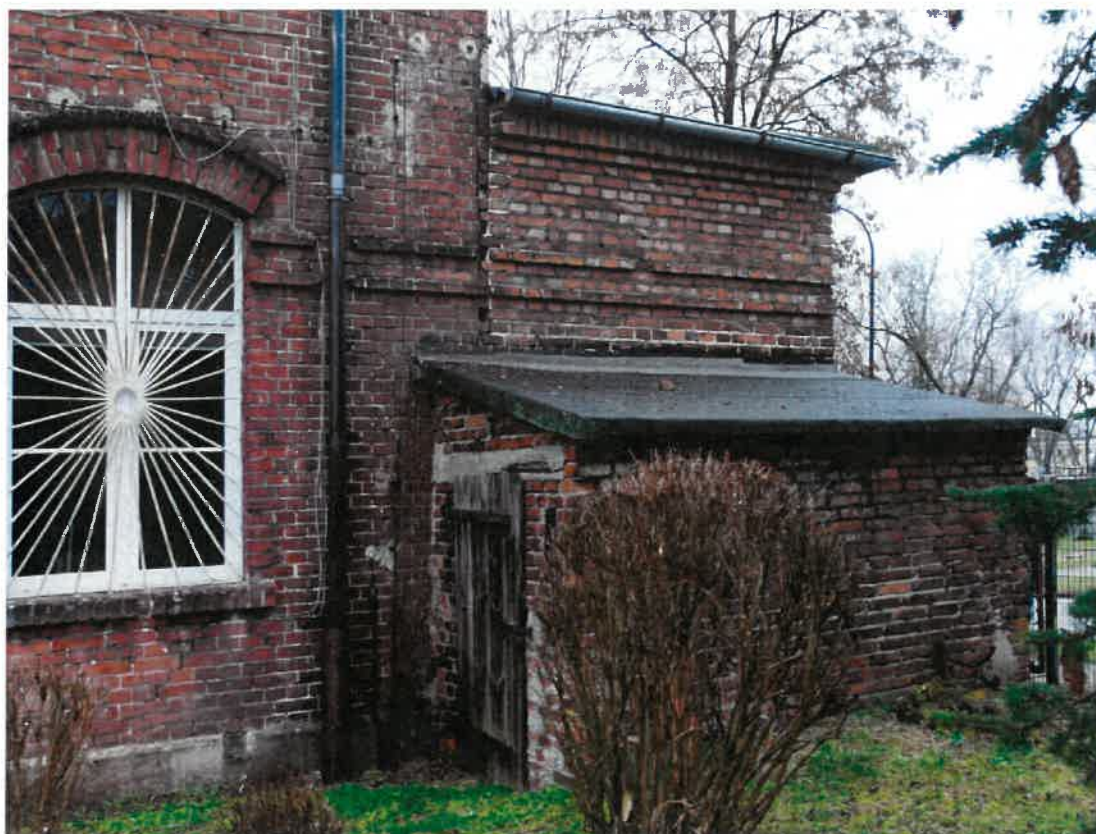
Styk elewacji południowej i przybudówek po stronie wschodniej.
