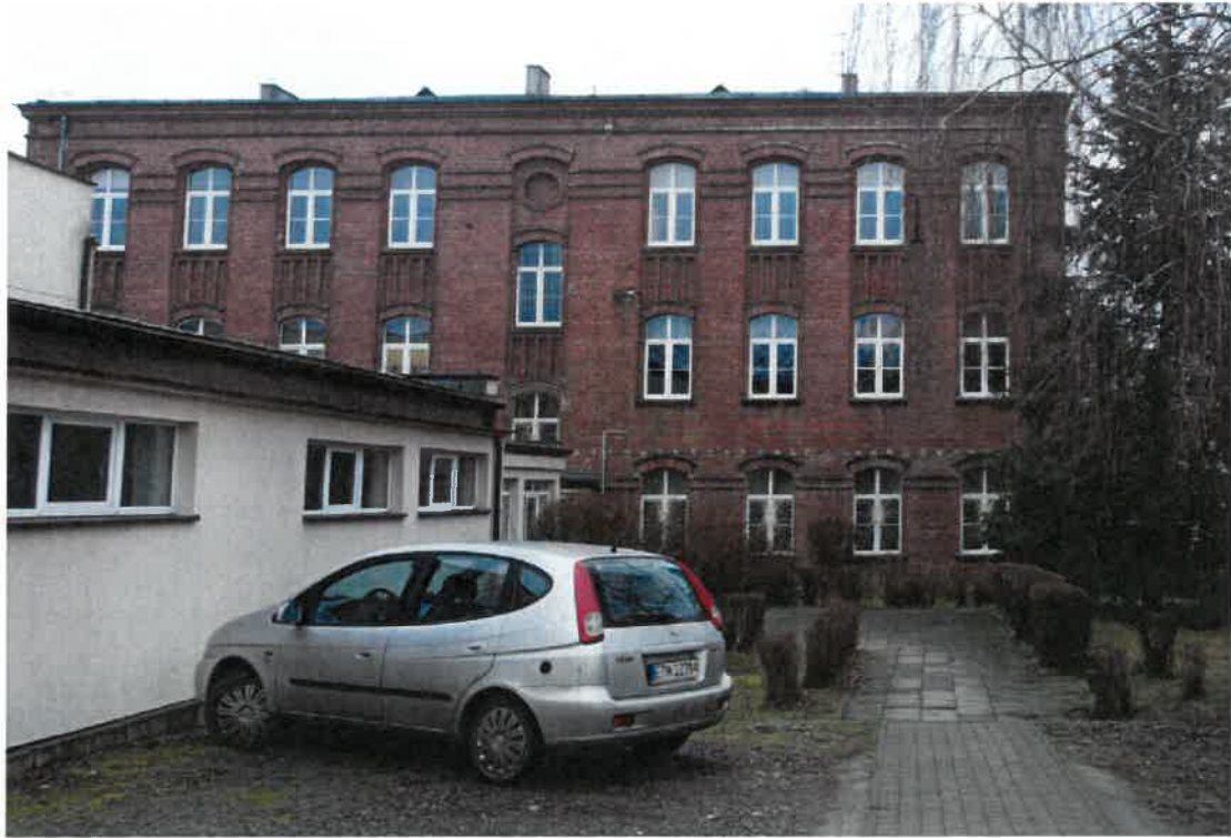
Elewacja południowa – widok ogólny.
